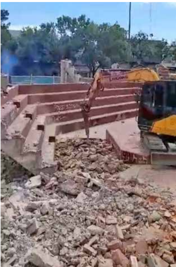
El lunes 11 de noviembre comenzó la demolición del anfiteatro y la promesa de su puesta en valor.
