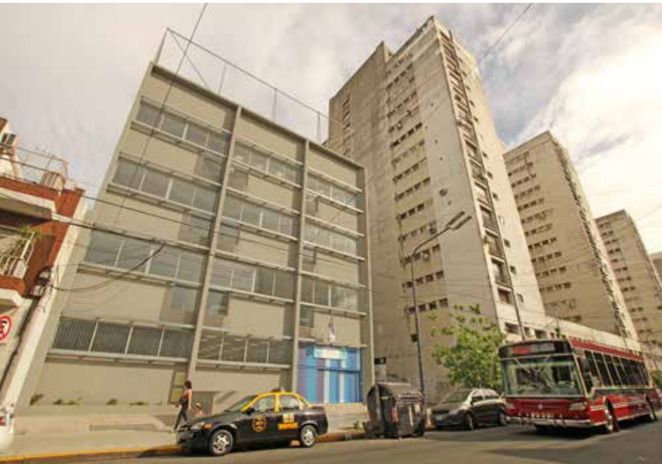
El edificio donde funciona el secundario y el terciario, con frente a Av. Jonte, fue inaugurado en el 2021, luego de una larga lucha de la comunidad educativa. Junto a él, las torres más altas del Hogar Obrero.
